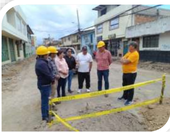
Fiscalización Barrio San Blas Regeneración Urbana Calle Velazco Ibarra
