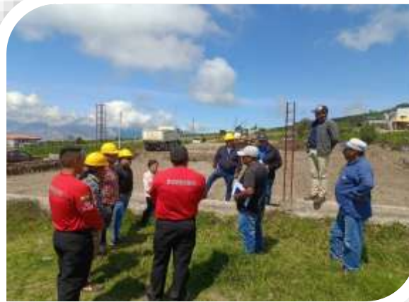
Fiscalización Barrio Construcción Estación de Cuerpo de Bomberos El Beaterio Malchinguí
