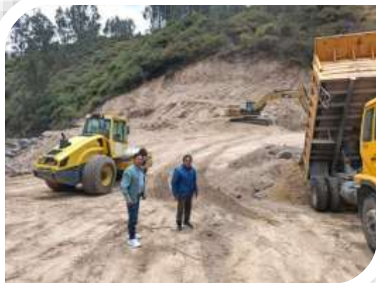
Fiscalización Angumba - Relleno de la vía que une a la Comunidad San Luis de Ichisí
