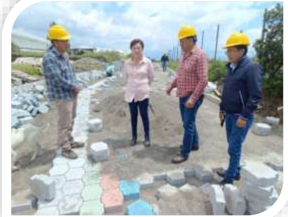
Fiscalización Adoquinado Vía Mojanda
