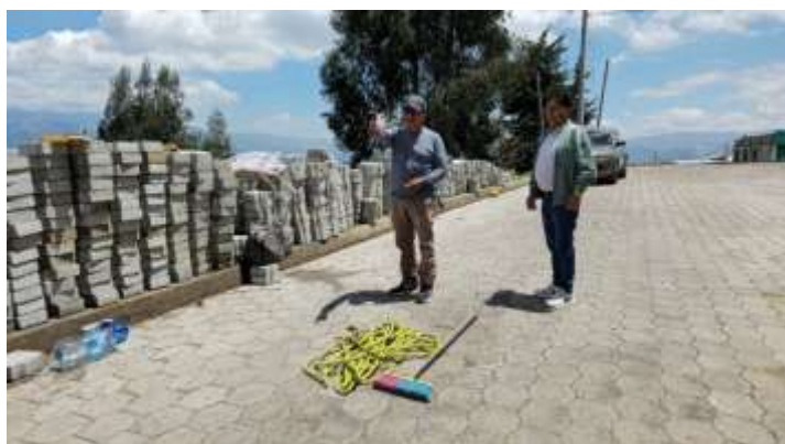
Recorrido de la construcción del adoquinado Barrio Moianda
