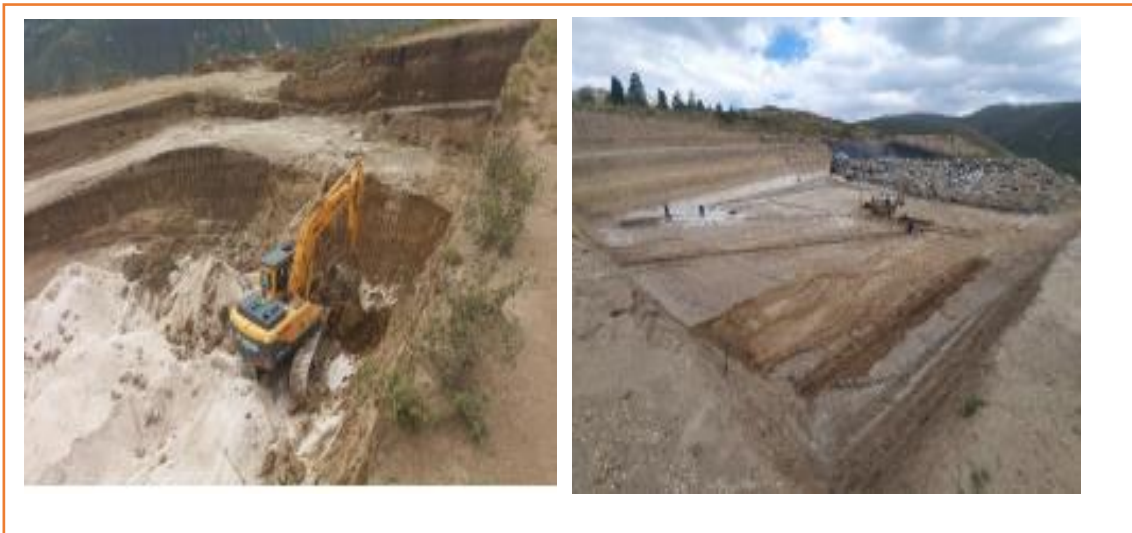
GRÁFICO 5. TRABAJOS DE AMPLIACIÓN DE CELDAS
