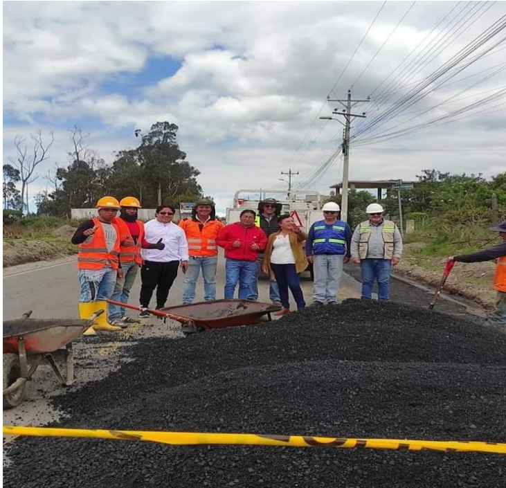
Asfaltado calle San Vicente de la parroquia de
