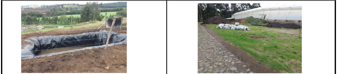
Fotografía 3. Inspección de reservorio
