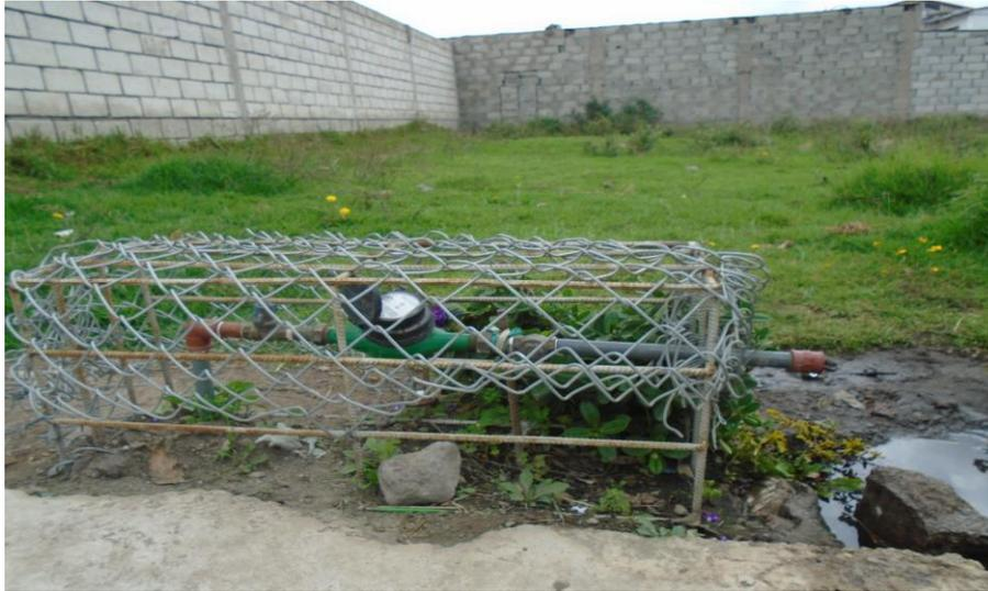
**FOTO N° 5:** Poca seguridad en los medidores de agua en Centro de Convenciones Tabacundo.
