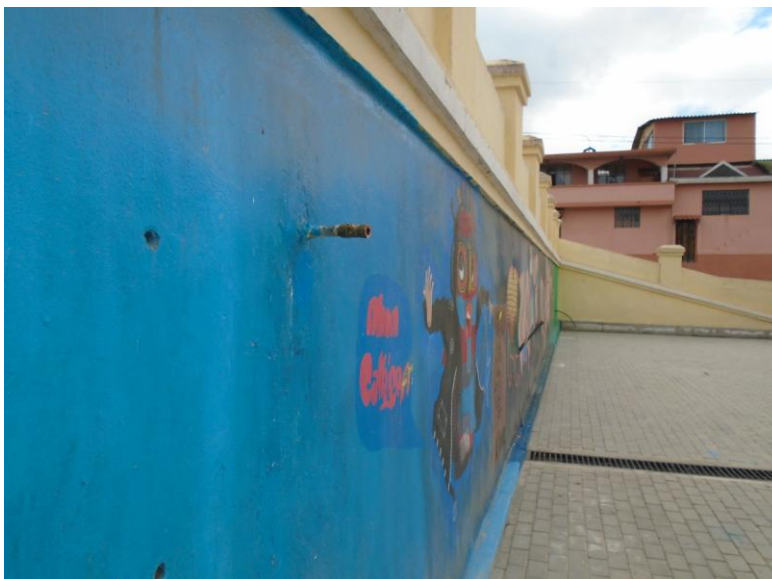
FOTO N° 2: Medidor y llave de agua en el parque de Malchingui.
